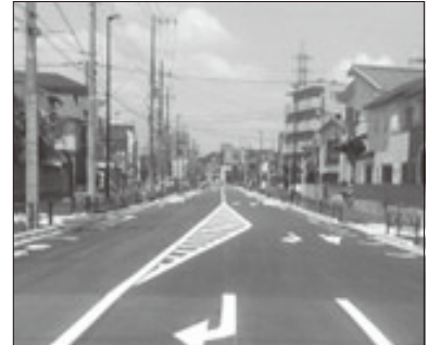
【道路拡幅区間】
