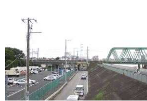
荒川・中川堤防
