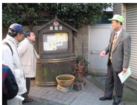
震災時に停電しても、手動のポンプで水がくみ上げられる「路地尊」。地域の防災のシンボルとなっています
