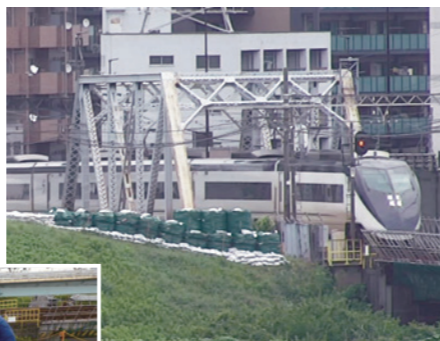
葛飾区合同水防訓練で設置された大型土のう(令和2年7月)
