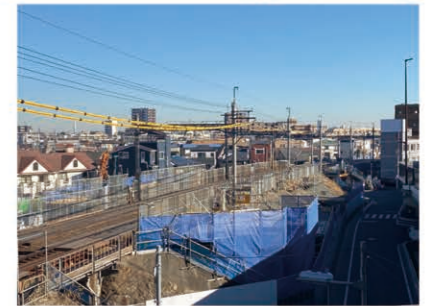
作業構台設置の様子
