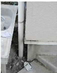
縦樋下部の地面
