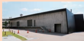
災害備蓄倉庫
