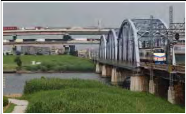
京成本線荒川橋梁
