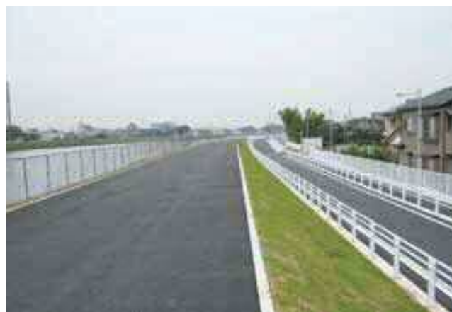
中川左岸の築堤・散策路（西水元）
