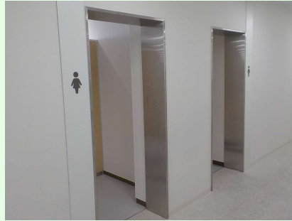
2階トイレ(増設)
