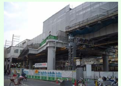
新たに設置を要請している箇所
