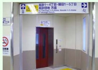
平成 19 年 10 月に完成した 南口エレベーター
