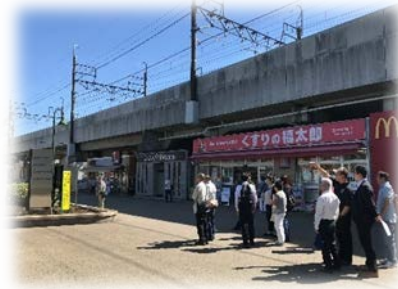
新鎌ヶ谷駅周辺(高架下利用)
