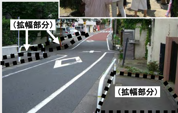
道路拡幅が進められる茶沢通り
