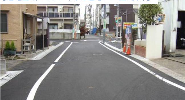
【道路整備の状況 (南北道路 A：整備後)】
