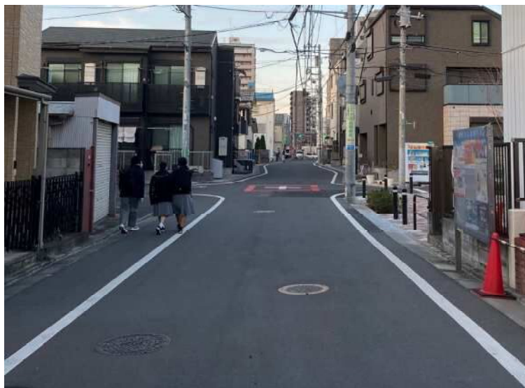
南北道路 A（整備後）
