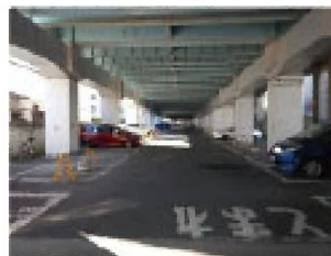
高架下の駐車場
