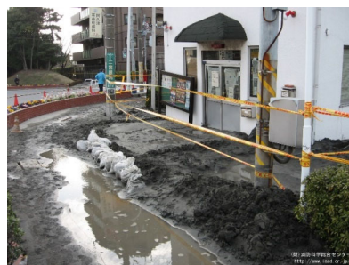
液状化の様子(千葉県浦安市) 出典:一般財団法人消防防災科学センター
