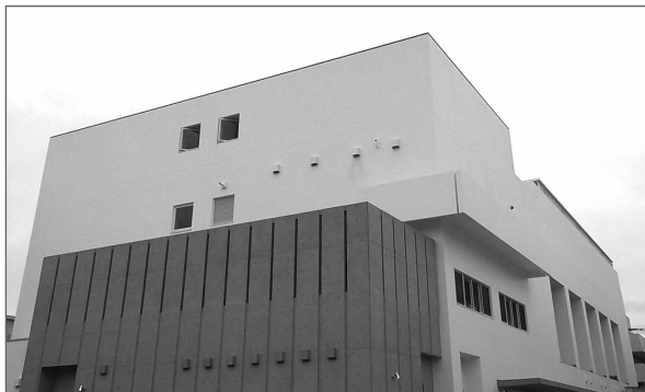
※上千葉小学校新体育館・プール棟
