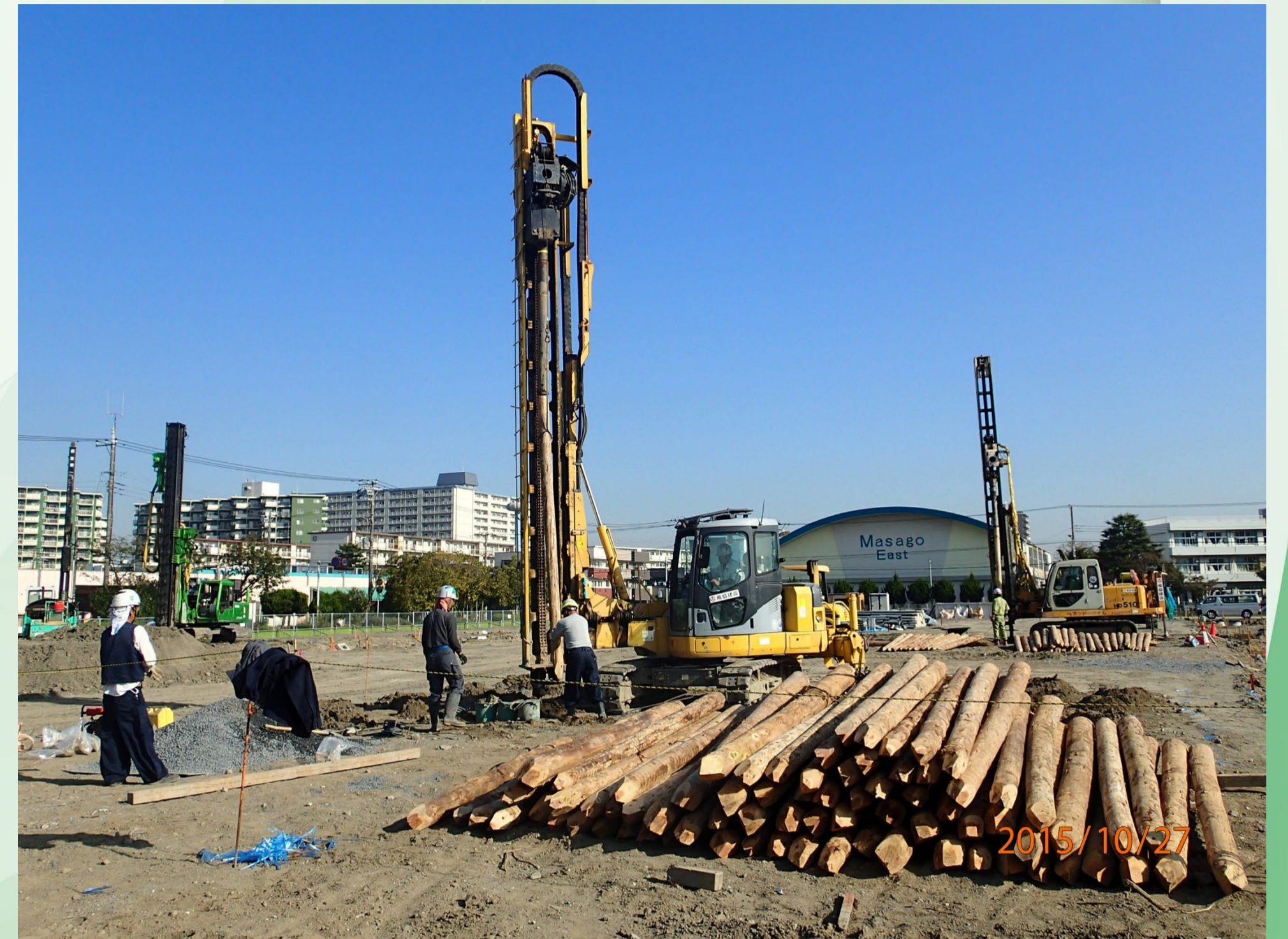
1.3ha大規模分譲住宅における液状化対策 (千葉県千葉市美浜区)
