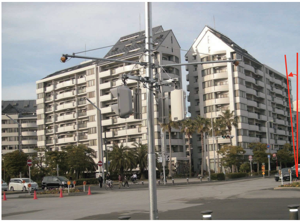
※建物の右側に比べて左側の沈下量が大きく、左側に傾いています。
