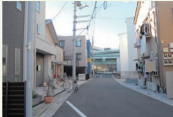
■整備工事完了後
