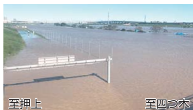
▲増水した荒川(令和元年10月13日撮影)
