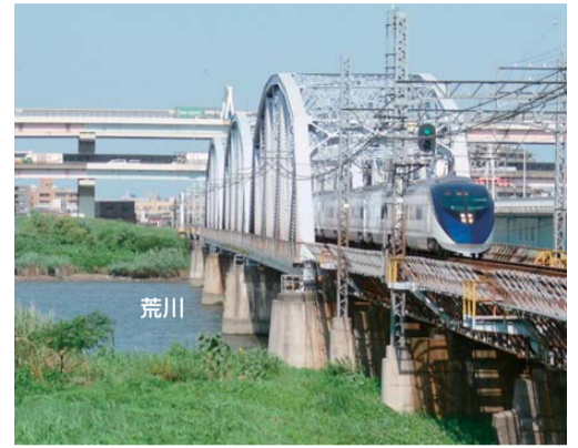
現在の京成本線荒川橋梁
