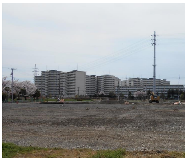
建替え中の都営高砂団地
