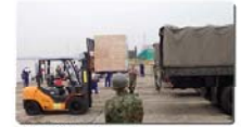
▲物資搬送設備 出典：関東地方整備局 平成30年11月9日、荒川口ロックゲート前
