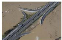
▲令和元年東日本台風において道路機能が確保された堤防設備(水戸島1IC付近)写真：国土交通省
