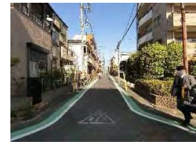
④東側道路から東方向
