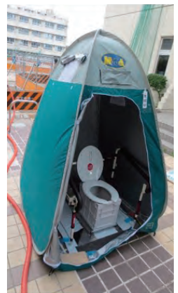
▲マンホールトイレ
