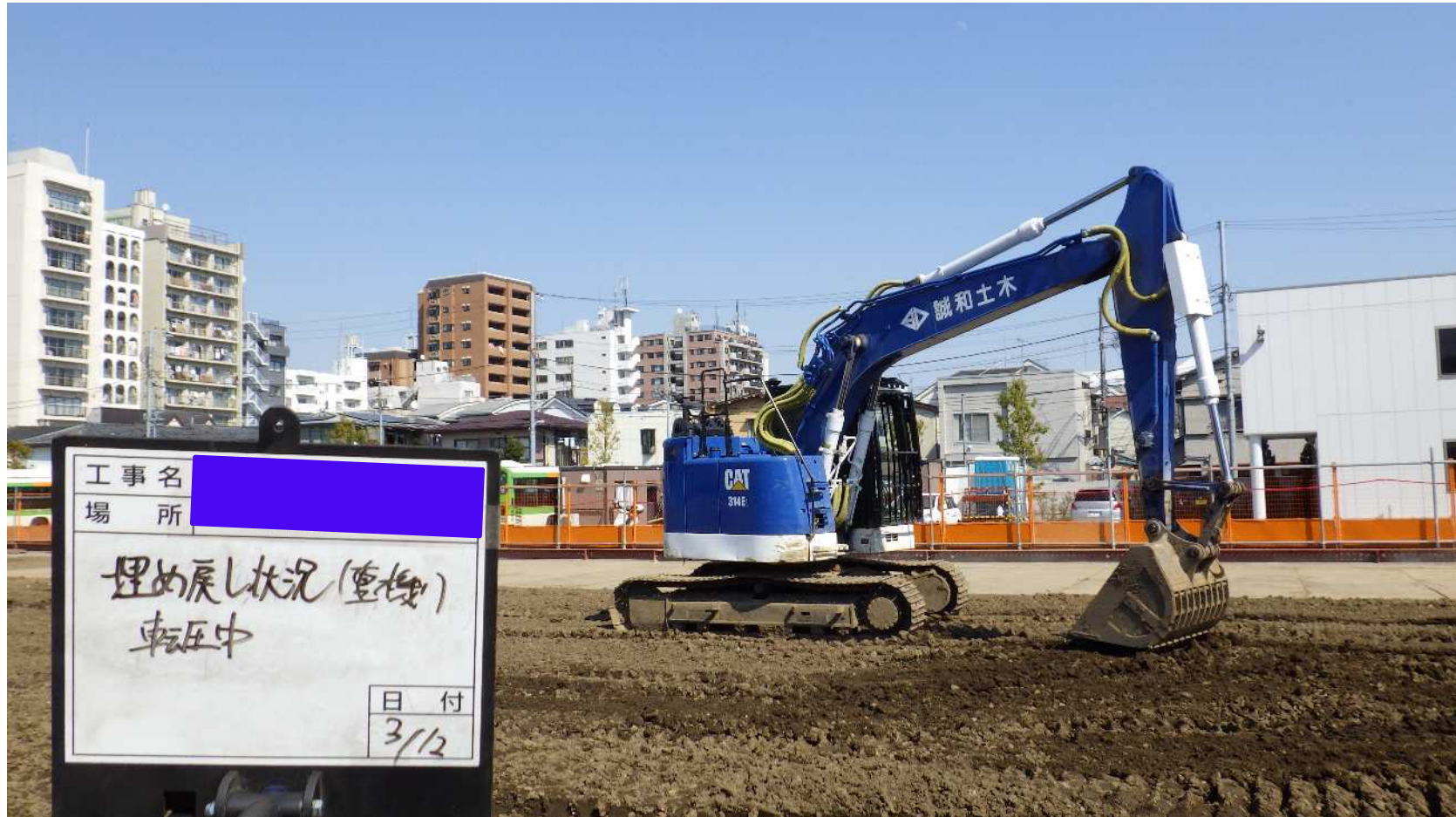
他現場の参考例(埋戻し・整地状況)
