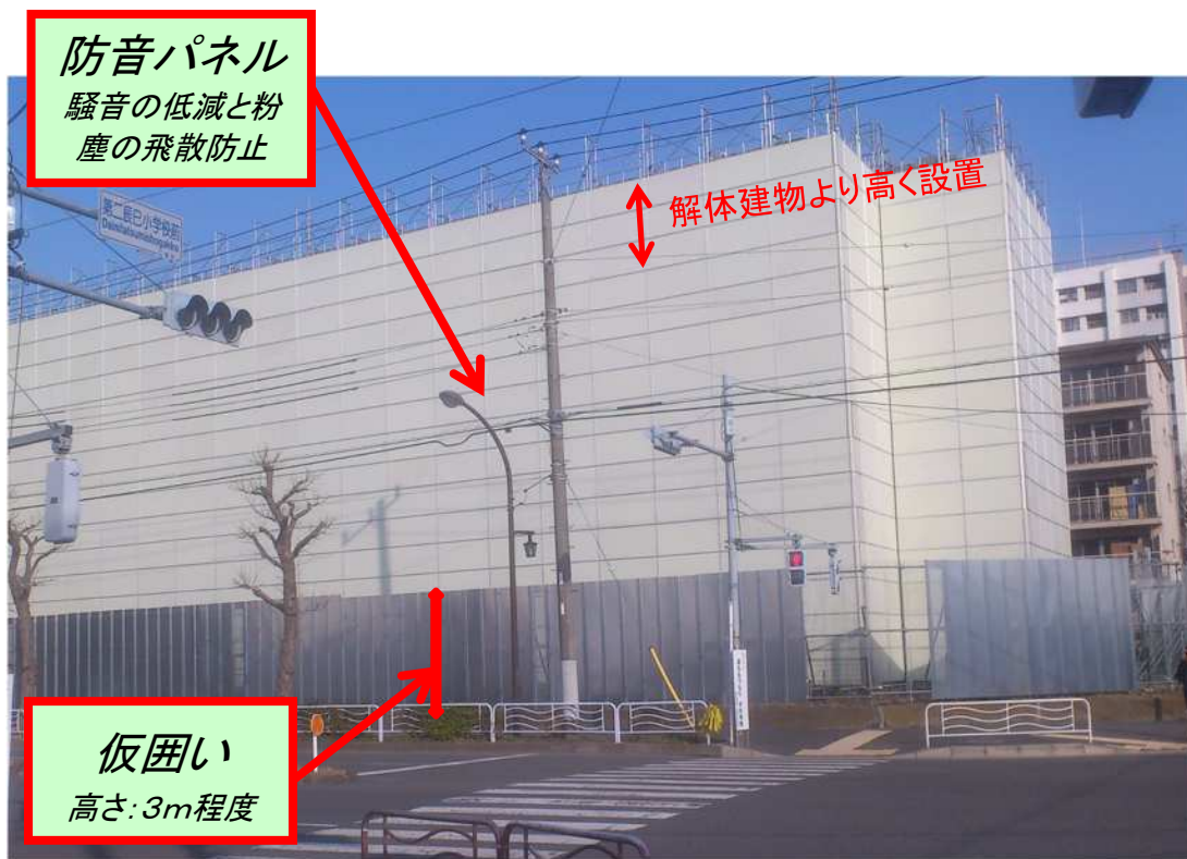
仮囲い/枠組足場+防音パネル
