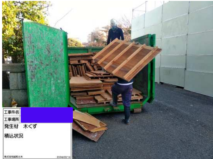
4トコンテナ車にて発生材（木くず）の搬出
