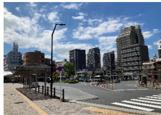
駅周辺に立ち並ぶ 中高層マンション
