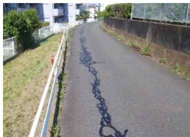
中川堤防道路
