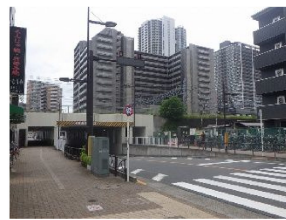
道路附属物：道路情報提供装置 (金町駅東側南北道路)
