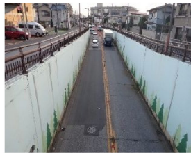
道路土工構造物：擁壁 (新宿五丁目付近)
