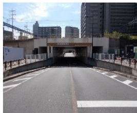
道路土工構造物：大型カルバート (金町駅東側南北道路)
