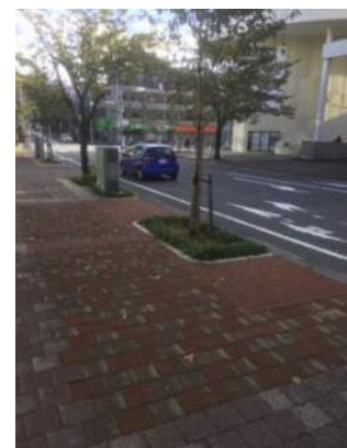
樹木の更新が完了し、舗装された歩道（横浜市）
