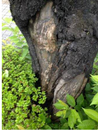
車接触による傷から腐朽
