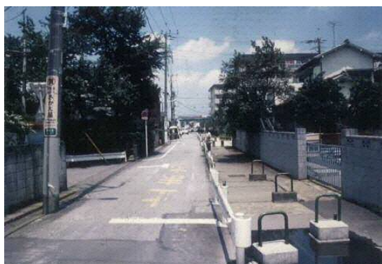
暗渠化された道路脇の水路
