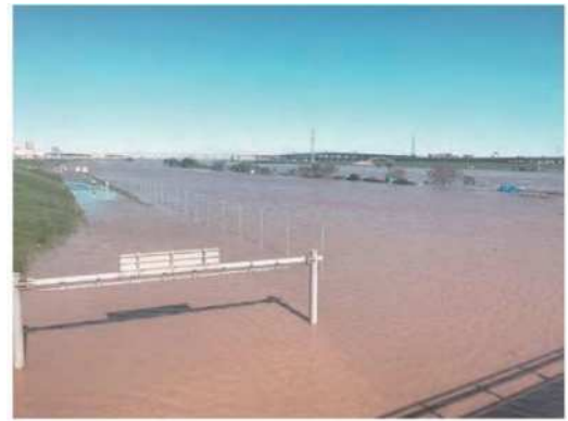
令和元年東日本台風にて増水した荒川
