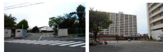
森永乳業東京工場
