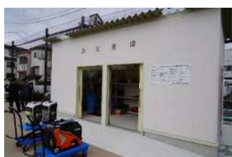
防災資器材倉庫
