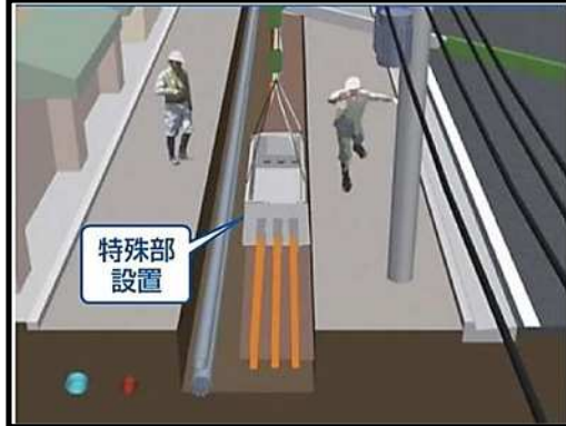
無電柱化に必要な電線共同溝を埋設します。
