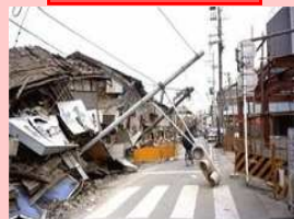
電柱崩壊による通行の妨げ
