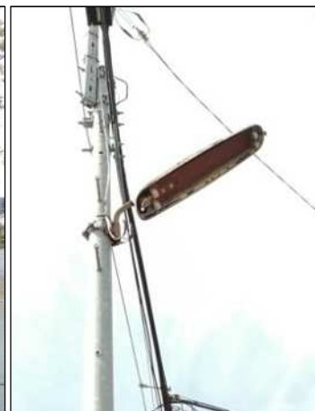
その他（灯具破損）
