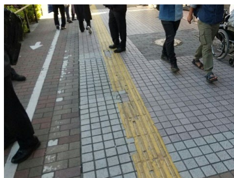
新小岩駅南口の視覚障害者誘導用ブロックは劣化が進んでいました。
