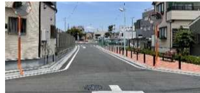
▲道路の拡幅後
