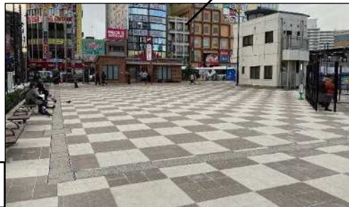
南口駅前広場（島地内） ・令和2年度完成
