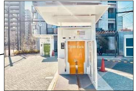
東南地区地下機械式自転車駐車場 ・令和4年9月開設（計408台）
