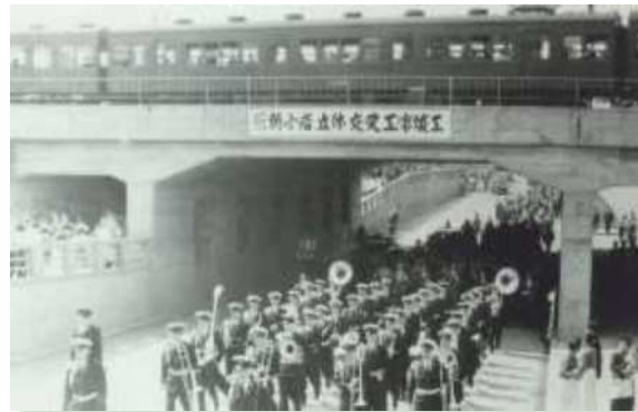
新小岩駅立体交差工事竣工
