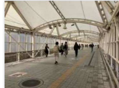
朝の時間帯は通行量が多いスカイデッキつつみ
