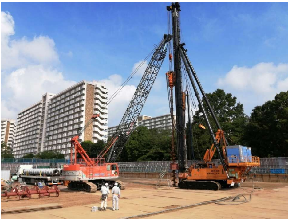
クローラクレーン
