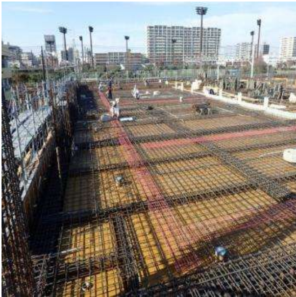
鉄筋・型枠
