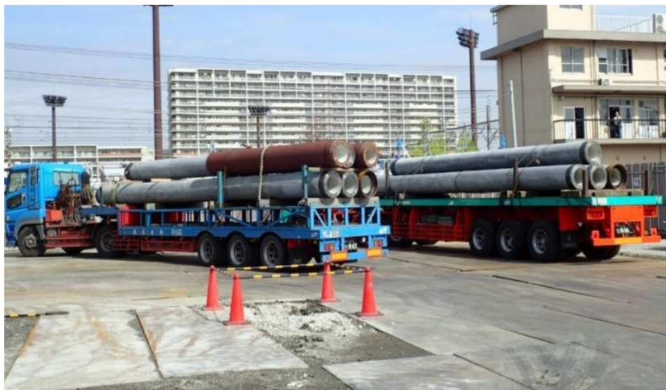
杭材を搬入するトレーラー
