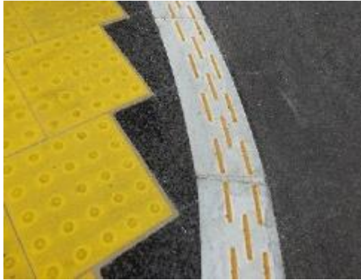
歩車道間の段差を無くした歩道巻き込み部
