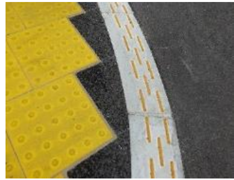
歩車道間の段差を解消した 歩道巻き込み部
