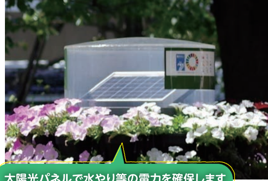
太陽光パネルで水やり等の電力を確保します
